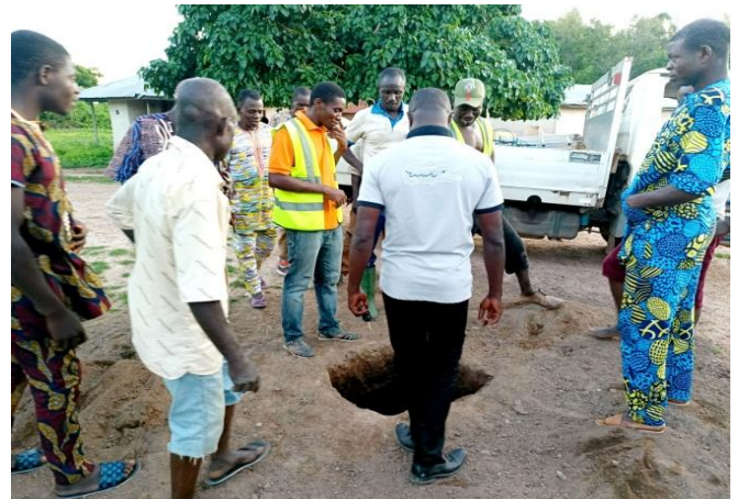
beim Ausheben und Zementieren der Sockel sowie bei der Aufrichtung der Laternen – alles reine Handarbeit
