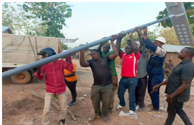
bei der Aufrichtung Laternen – alles Handarbeit
