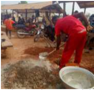
Vorbereiten des Betonsockels
