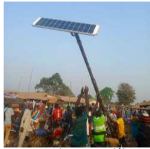
Montage in Angaradébou
