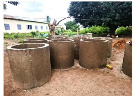
*Vor Ort gefertigte Betonröhren werden eingelassen*
